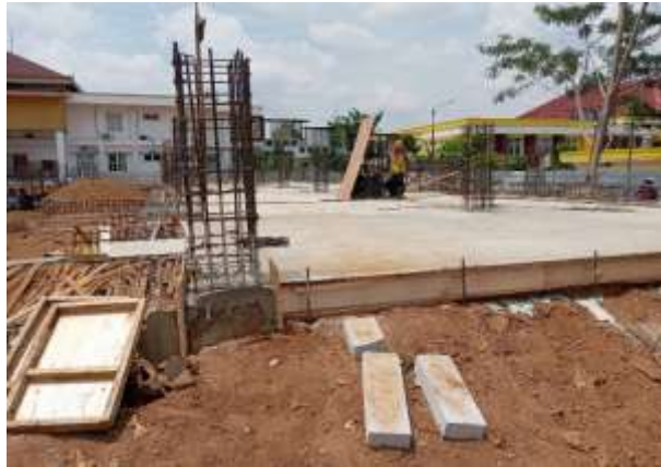
Pembesian lantai kolom Lantai 1
