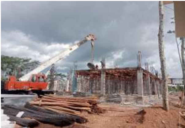
Pembesian Balok Lantai 2
